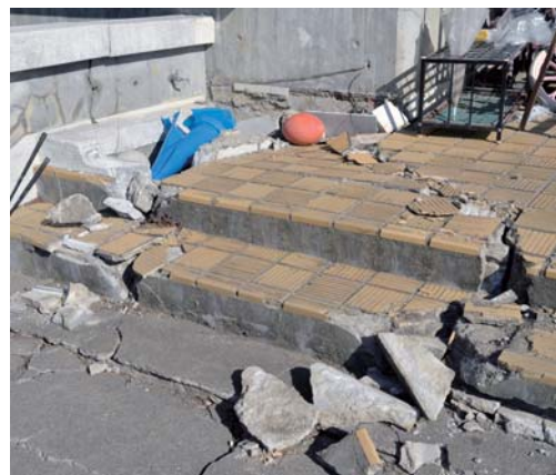
地震による地盤沈下で大きく傾いた校舎、ひび割れた玄関（東北朝鮮初中級学校）
