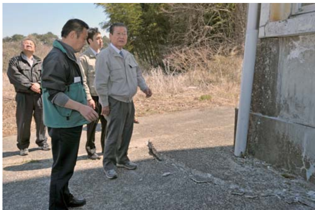
地震による地盤沈下で大きく傾いた校舎、ひび割れた玄関（東北朝鮮初中級学校）
