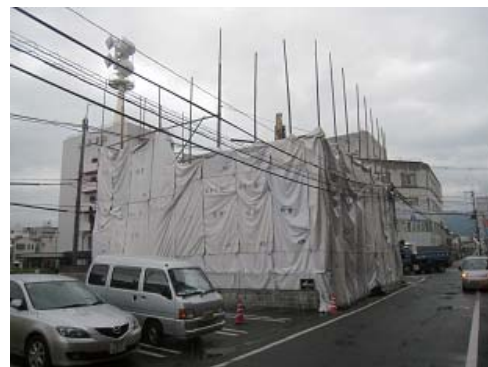
解体作業がすすむ奈良朝鮮会館
